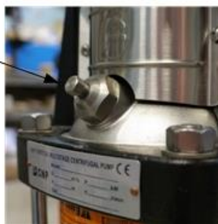
Рис. 7 Пробка на насосе для выпуска воздуха.
