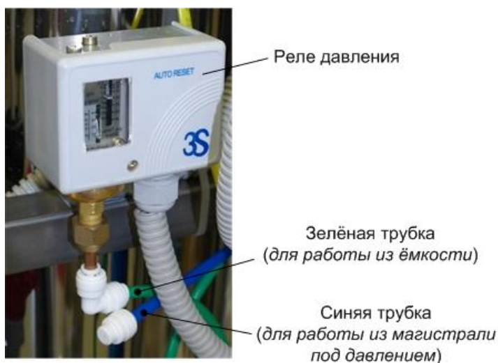
Рис. 5 Реле давления и трубки.
