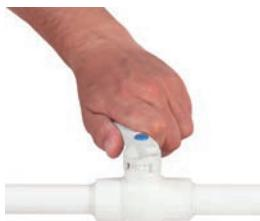
1. Перекройте подачу воды запорным вентилем установленным перед системой очистки воды.
