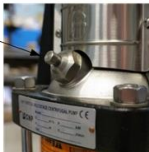
Рис. 6 Пробка на насосе для выпуска воздуха.
